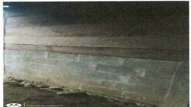
Foto 4 : se culminará las paredes por block
