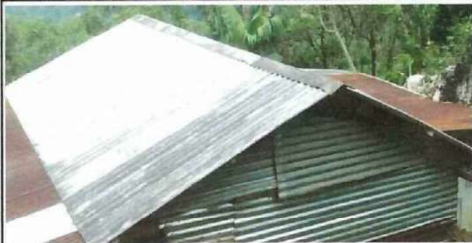
Foto 1: Sustrucción de láminas en mal estado
